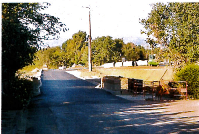
Le chantier de construction de la zone d'habitat individuel, pour assurer le passage des divers véhicules sur le chantier en formation est en cours. PHOTO/Photos C. S.
