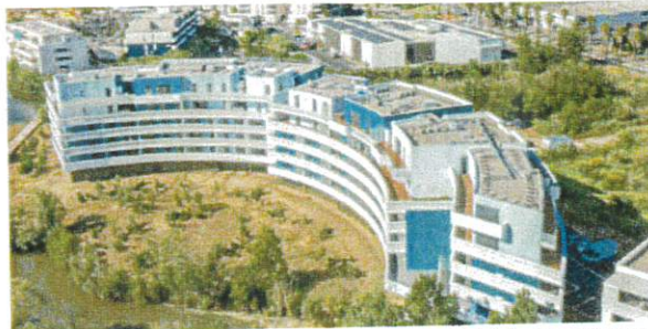
Début juin, le groupe Angelotti livrait le 1er bâtiment de sa résidence Bleu Odyssée, située dans le nouvel écoquartier Port-Alizés, à Canet-en-Roussillon (Pyrénées-Orientales). (Crédits : Angelotti)
